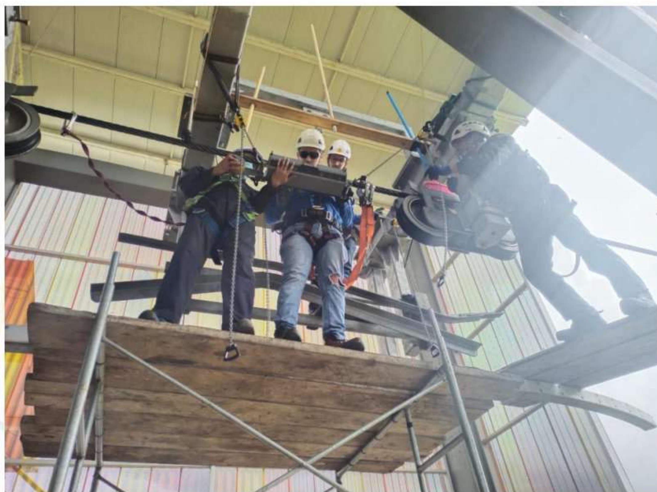
Fotografía No 15 y 16: Inspección cable de acero
